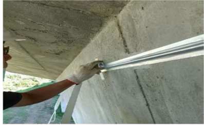
設置中の光ファイバケーブル
