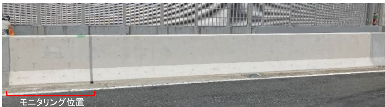
写真-5 中央分離帯の完成状況
