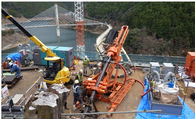
写真-1 ロータリーパーカッション式大型削孔機
