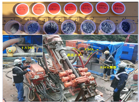
写真-4 削孔スライム採取状況
