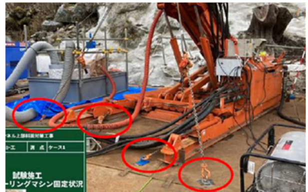
写真-2 削孔機固定状況
