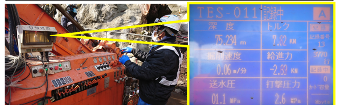
写真-3 削孔機械データ取得状況
