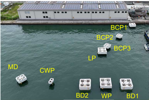
図-5 上部工設置後の全景
