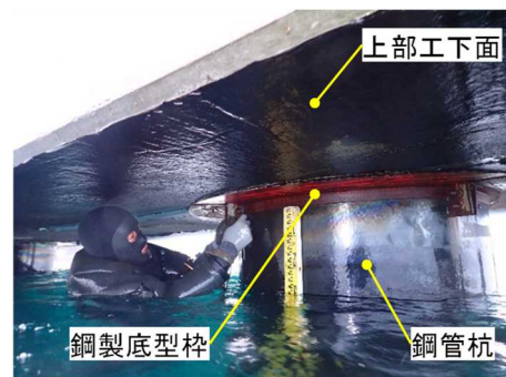
図-1 潜水士による底型枠設置状況
