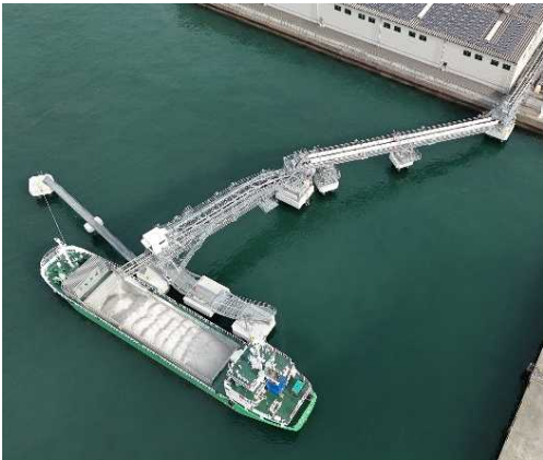
図-4 荷役棧橋の全景
