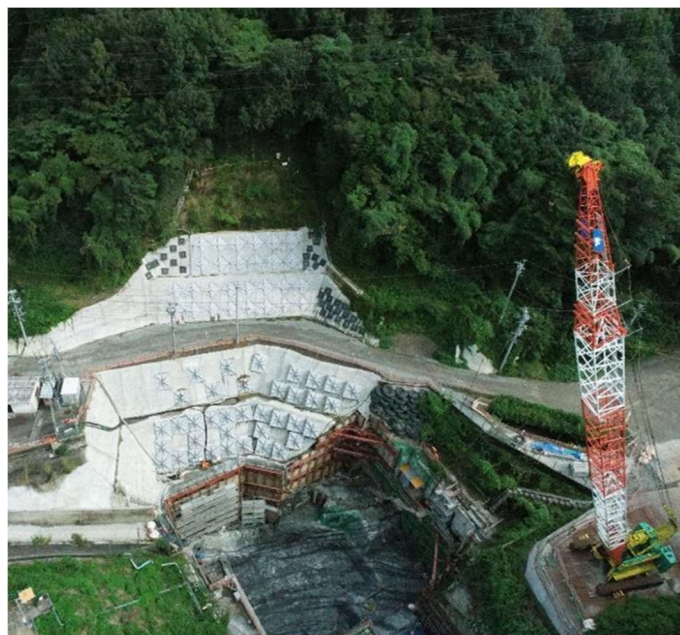
写真-4 対策工完了
