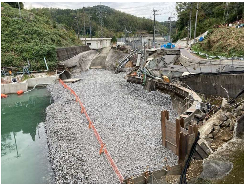
写真-3 応急対策（押え盛土）の施工状況
