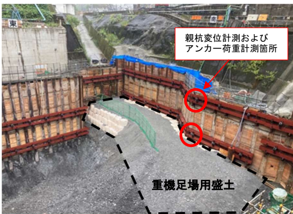
写真-1 台風通過直前の現場状況
