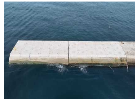
写真-6 完成写真
