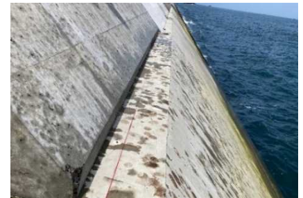
写真-5 上部ブロック鋭角部除去
