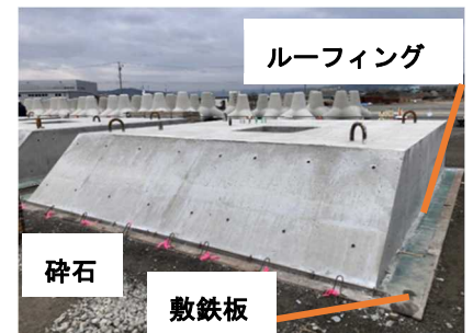
写真-1 施工ヤード状況
