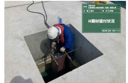
写真-4 H形鋼設置状況
