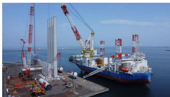
写真-1 風車部材の積込み
