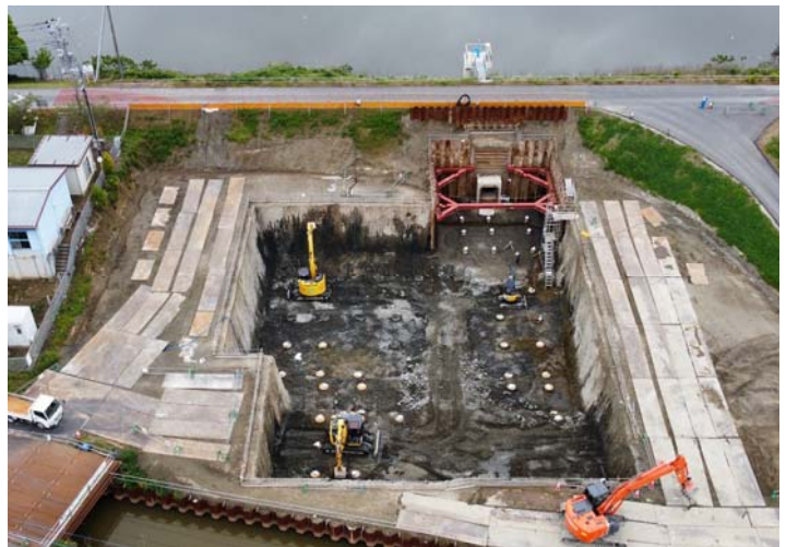
写真-1 地盤改良土留めの掘削完了
