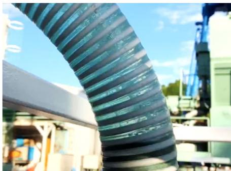
写真-1 曝気処理における排水への炭酸ガス添加状況
