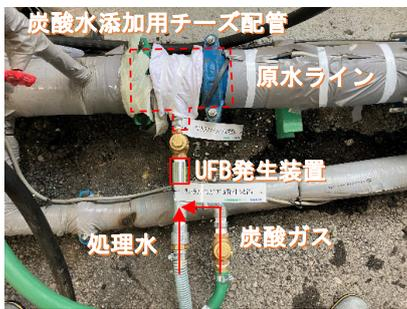
写真-3 ウルトラファインバブル発生装置設置状況
