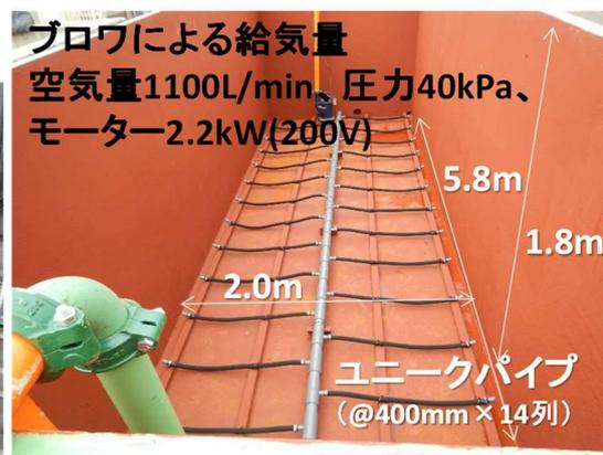
図-11 水槽内の散気管
