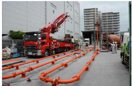
写真-1 圧送試験配管設置状況
