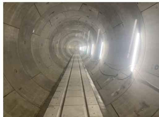
写真-11 セメント・ゼロ型の現場設置状況
