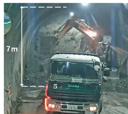
図-11 実トンネルでの実証試験
