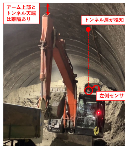
図-12 実トンネルでの実証試験
