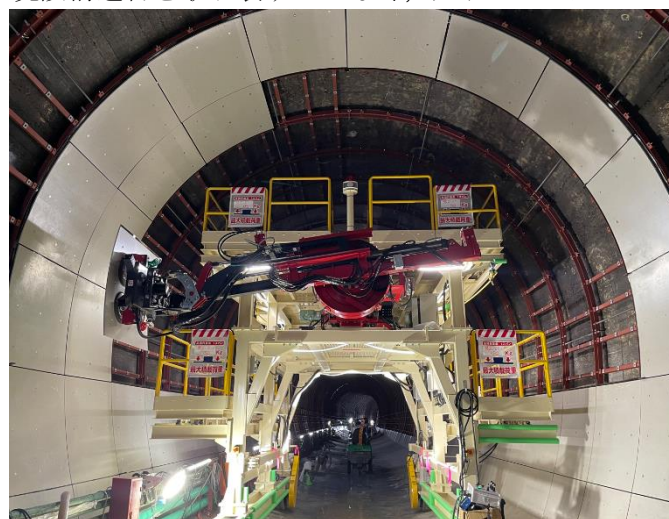
写真-5 パネルライニング台車の全景
