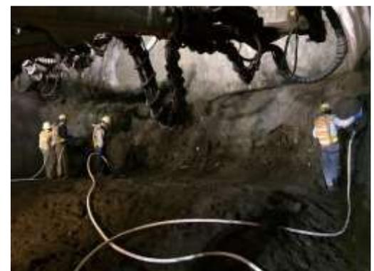
写真-2 装填機 4 本による装薬状況
