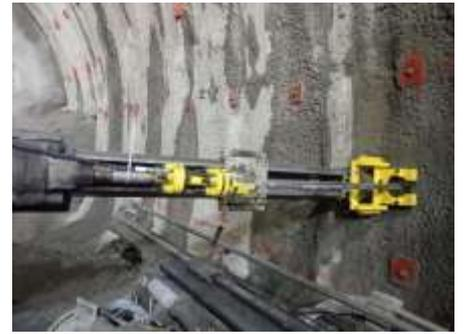
(f) ボルト挿入・座金設置状況
