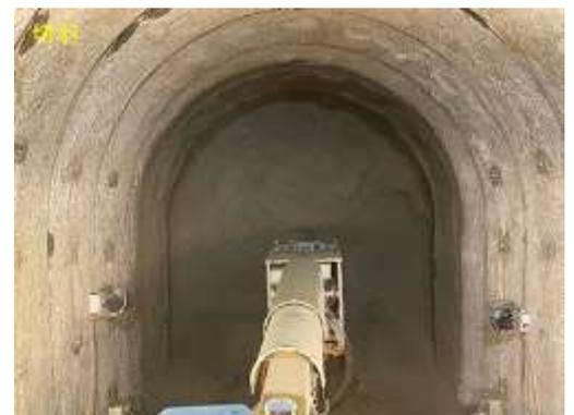
写真-6 遠隔吹付け状況
