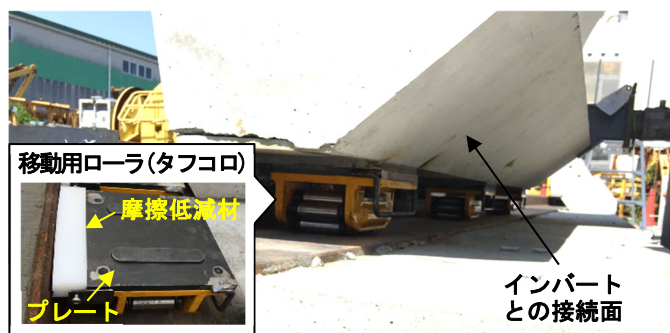
写真-2 PCa 覆工の脚部状況
