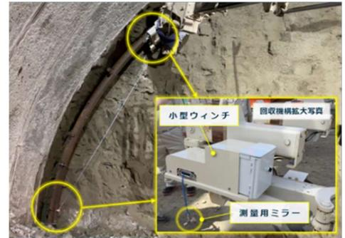
写真-5 ミラー回収機構
