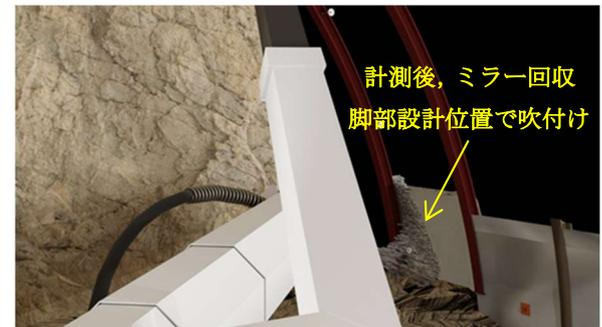
図-5 右支保工 締結前の脚部吹付け
