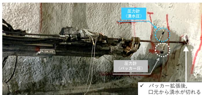
写真-2 穿孔探査ならびに湧水量測定結果
