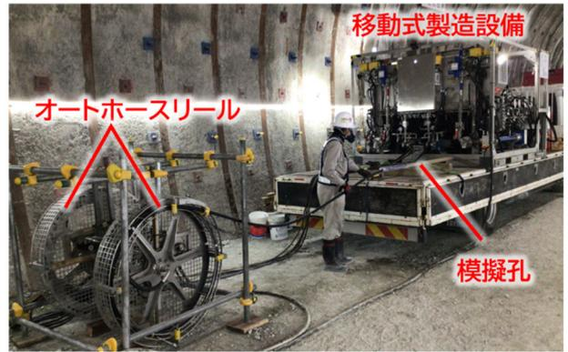
写真-3 模擬孔を使った事前の装填トレーニング
