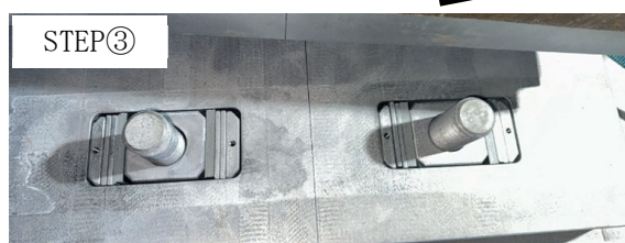
(c) 隙間埋め PL (フィラー) 設置完了
