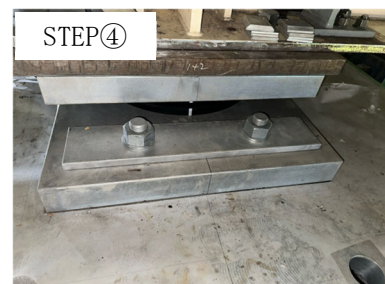
(d) 支承設置完了
