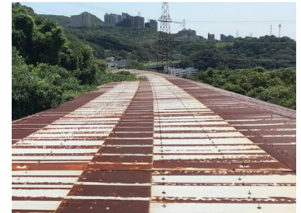
写真-7 環境 SH の現況（屋根部）
