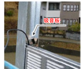
写真-8 吸音板設置状況（現況）
