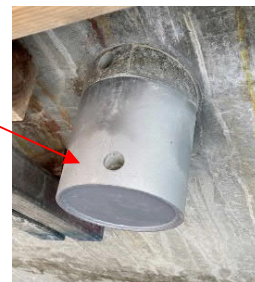
写真-4 貫通アンカー取付状況
