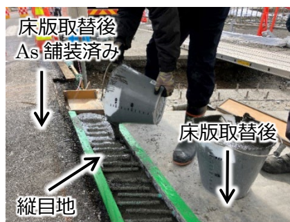
写真-5 縦目地の打込み状況
