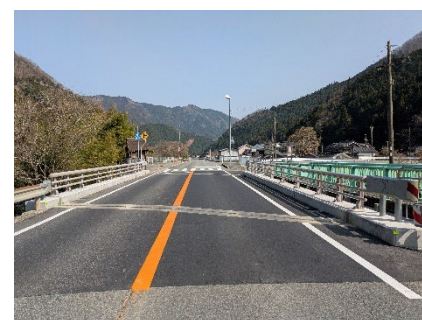
写真-7 施工完了後全景
