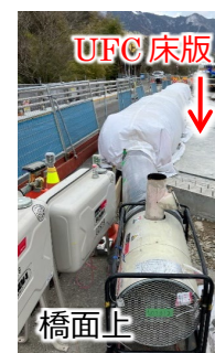
写真-6 給熱養生状況
