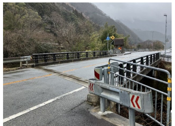
写真-1 新中島橋（補修前）
