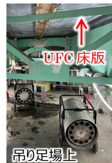
写真-3 給熱養生状況
