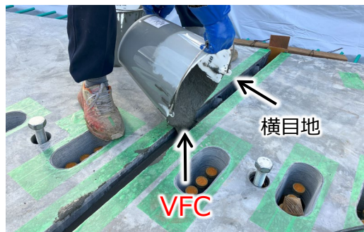
写真-2 横目地の打込み状況
