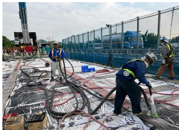
写真-6 主桁ケレン状況
