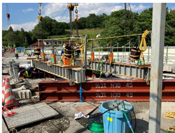
写真-2 床版引剥し機による既設床版撤去状況
