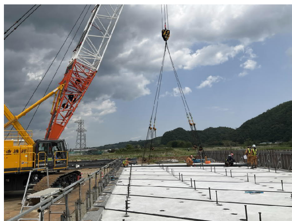
写真-7 仮組状況
