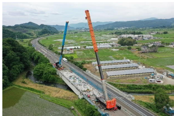
写真-1 クレーン2台による施工状況
