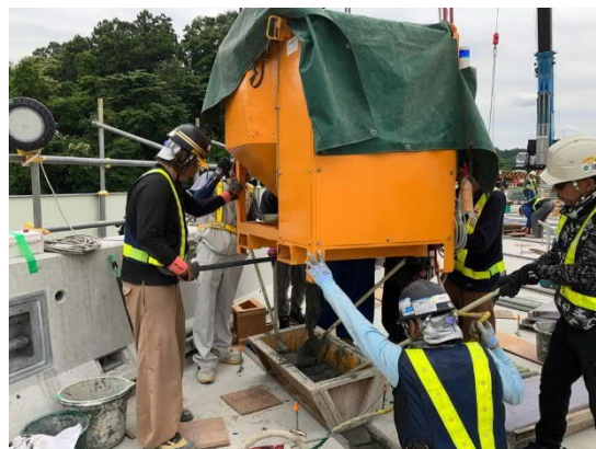
写真-11 床版間詰部の施工状況
