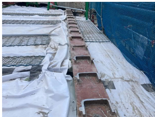
写真-4 既設床版撤去後の残存馬蹄形ジベル
