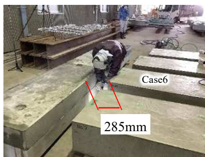
(b) JT 施工
