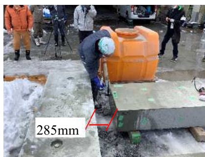
(a) WJ 施工
