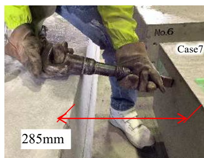
(c) B 施工
