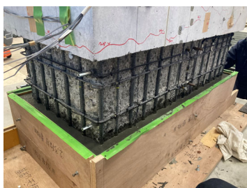
(b) UHPFRC 流込み
