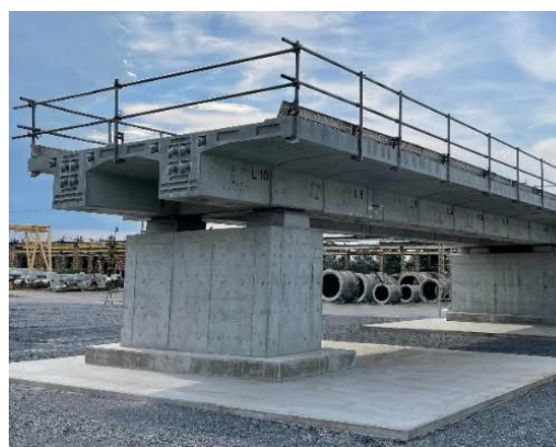
写真-7 架設完了写真(2)
