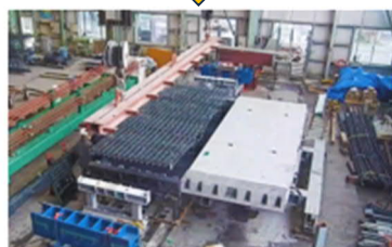
・ 型枠設置 ・ 鉄筋かご設置 ・ PC 鋼材設置
