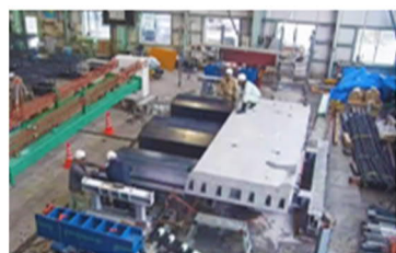
・ OLD セグメント設置
