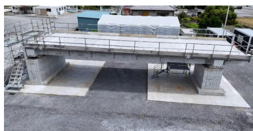
写真-6 架設完了写真(1)
