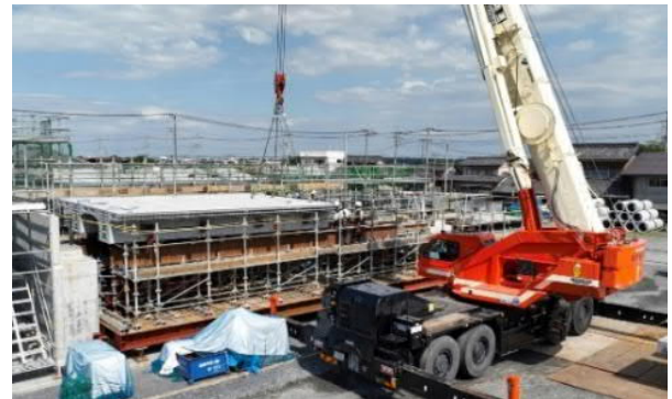
写真-1 試験施工風景
