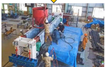
・ プレテン PC 鋼材緊張 ・ コンクリート打込み ・ 蒸気養生
