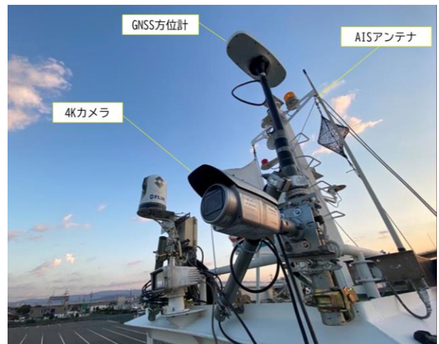
写真-2 機材設置状況
