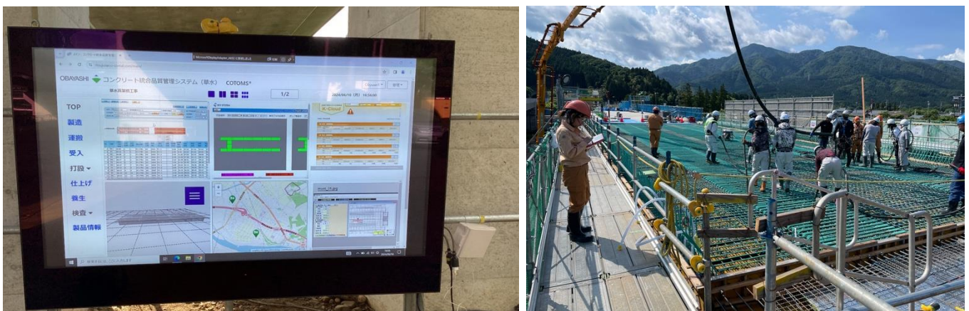
図-3 統合管理システム「COTOMS」を使用した打設管理の検証状況
