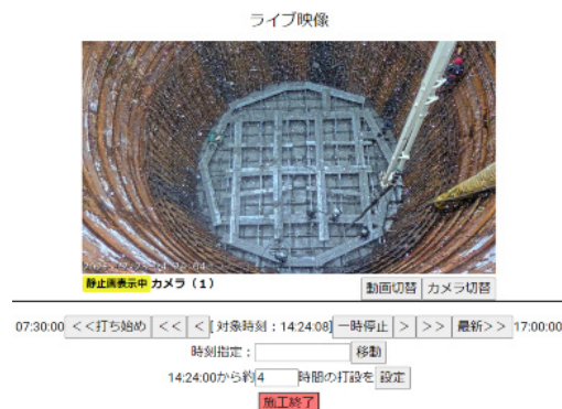
図-8 ライブ映像（深礎杭）
