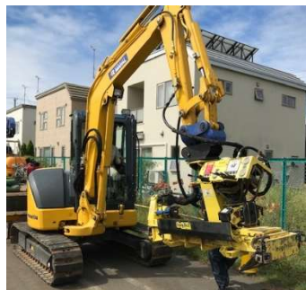
写真-2 フレックスドリル工法 2)
