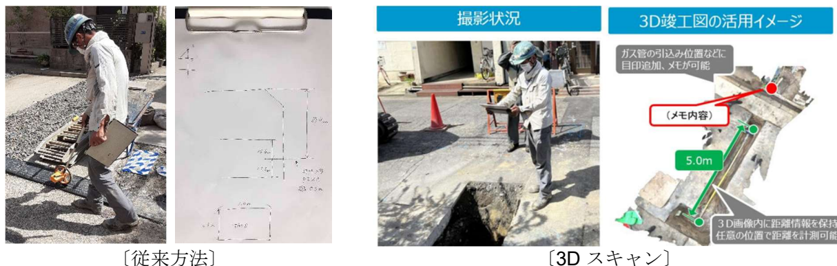
写真-5 現場での配管延長の測長方法
