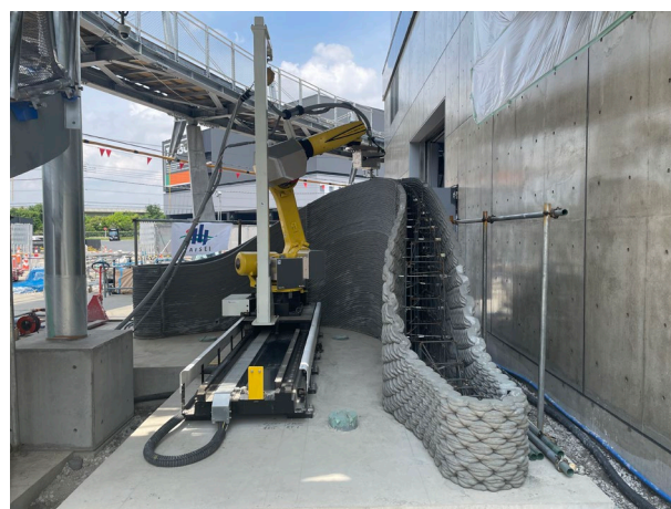
写真-3 オンサイト 3DP 型枠完成時の状況
