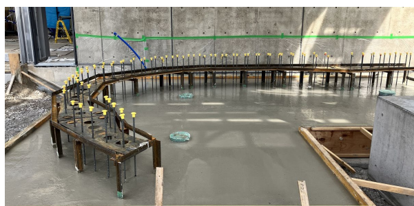
写真-1 架台を用いた鉄筋位置精度の確保
