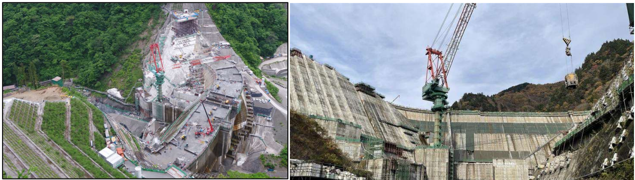
写真-1 ダム現場におけるタワークレーンの設置状況
