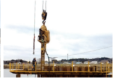
鋼矢板打設状況(近景)
