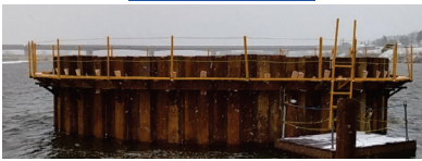
鋼矢板打設完了
