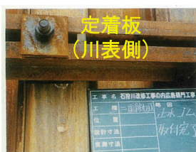
川表側漏水防止対策 (北海道開発局)
