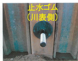
川表側漏水防止対策 (関東地方建設局)
