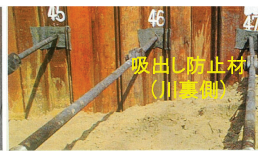
川表側中詰め土流出防止対策 (北陸地方建設局)
