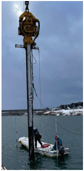
導枠用杭打設
