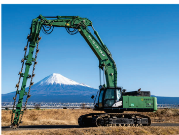
トレンチャ式 （パワーブレンダー工法）
