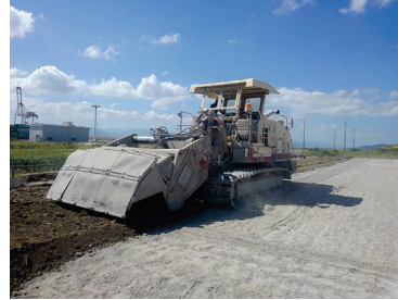
混合攪拌状況
