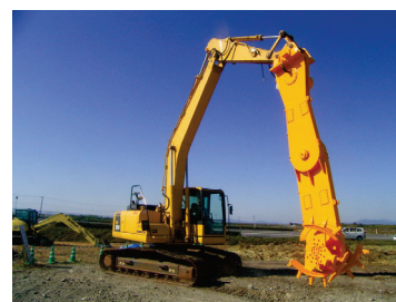
ロータリ式 （WILL工法）
