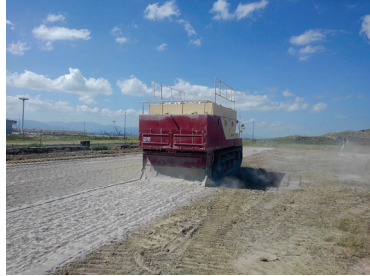
改良材の散布状況
