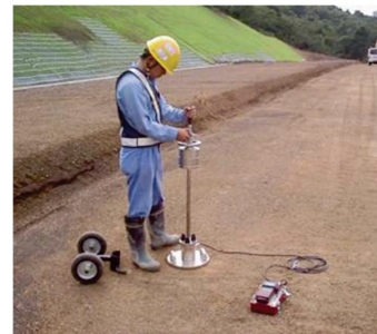
小型FWD試験状況 (提供: 東京測器研究所)
