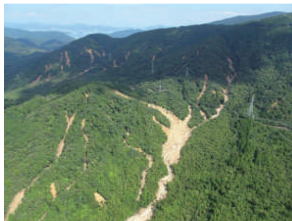
図-6 図-3の左側の本岳周辺の土砂移動の一例 源頭部の崩壊地周辺斜面は勾配15度程度と非常に緩い。また、崩土の流下後すぐに流路幅が広く拡大している。(2018年7月10日撮影)
