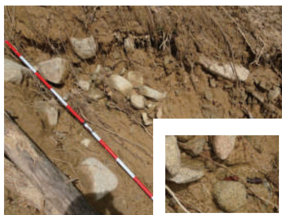
図-7 図-6の緩い源頭部周辺に見られた水の湧き出し痕と実際の湧水(2018年7月21日撮影)
