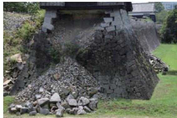
写真-1 地震による熊本城の石垣崩壊
