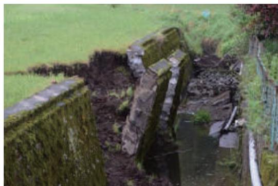
写真-2 地震による擁壁の崩壊 (益城町)
