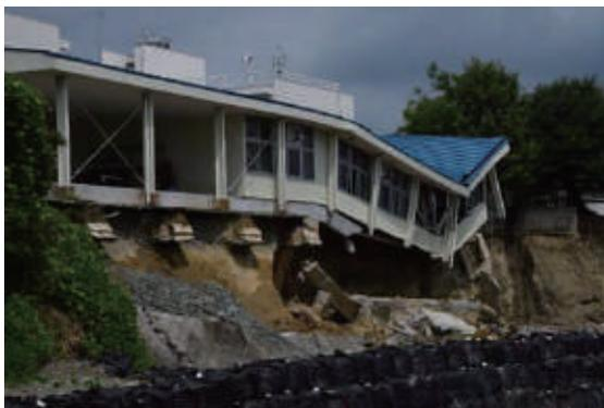
写真-4 中学校横の護岸の崩壊（朝倉市）
