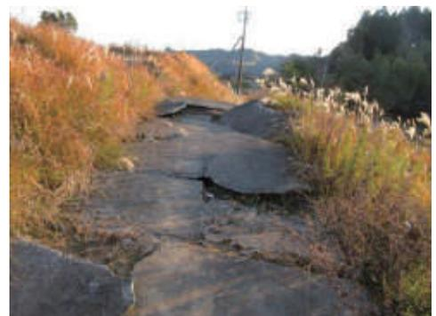
写真-8 地すべりにより屈曲した農道
