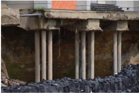
写真-3 校舎基礎下の剥きだしの支持杭
