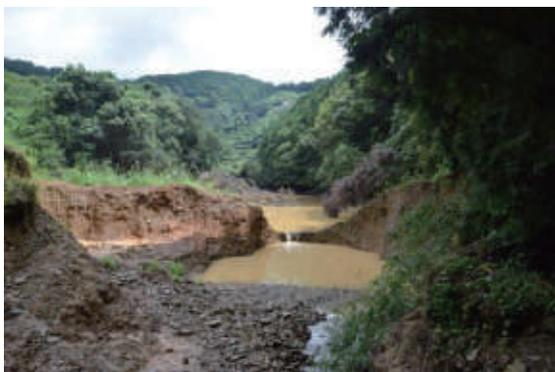
写真-5 ため池堤体の流出（朝倉市）
