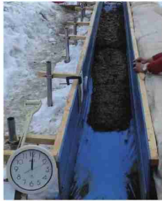
写真-3 泥流流下状況（陰が映らない敷設厚 7.5cm の例）
