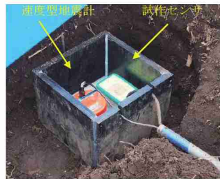
写真-2 計測機器の埋設状況
