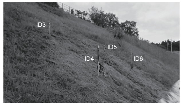
写真-1 現地計測の様子
