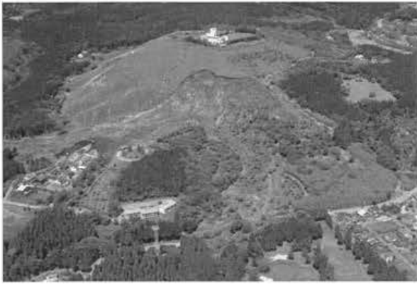
写真-8 高野台の地すべり性崩壊
