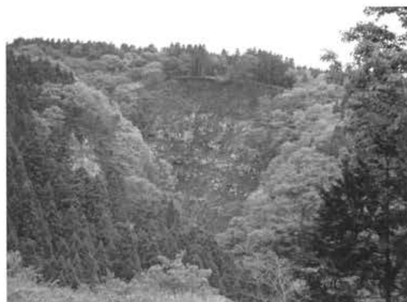
写真-2 山王谷川中流域の風化溶岩の崩壊
