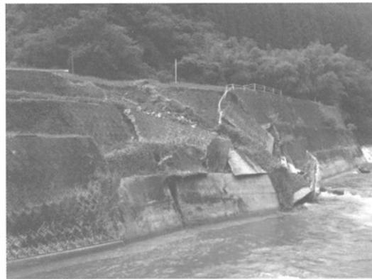
写真-6 護岸流失による擁壁崩壊（八女市）
