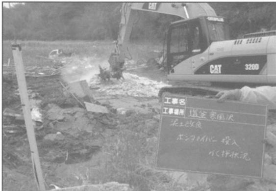
写真-5 原位置搅拌工法による改良状況
