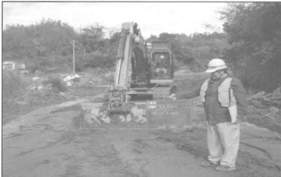
写真-6 仮設道路築造-締固め（立会い確認）
