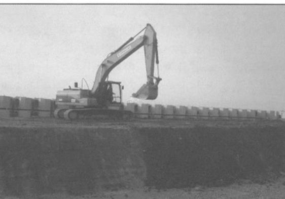
写真-14 改良翌日の敷均し・締固め状況
