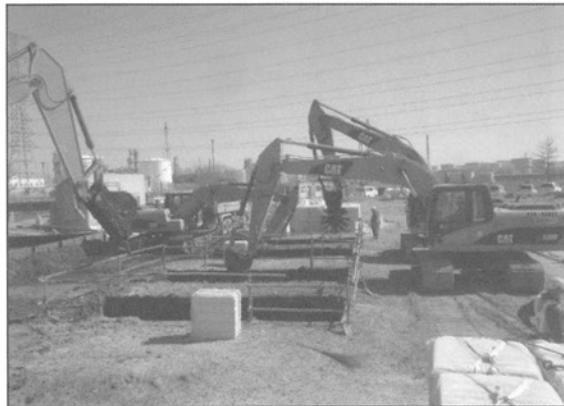
写真-3 繊維質固化処理土工法による改良の様子
