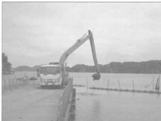
写真-8 バックホウによる津波堆積物の浚渫の様子
