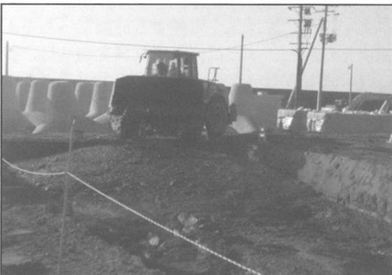
写真-12 土砂ピットへのヘドロの投入
