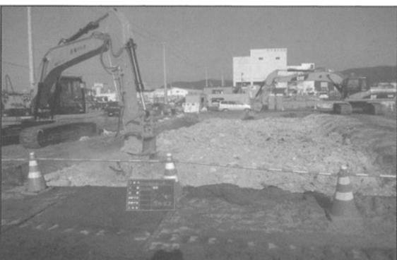
写真-13 ヘドロに古紙破碎物を混合している様子
