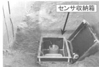
写真-2 振動検知センサ（円筒形オレンジ）の設置状況
