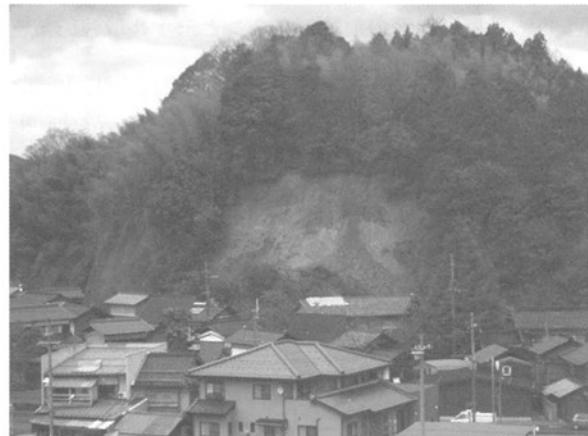
写真-1 人家裏切土斜面における崩壊事例
