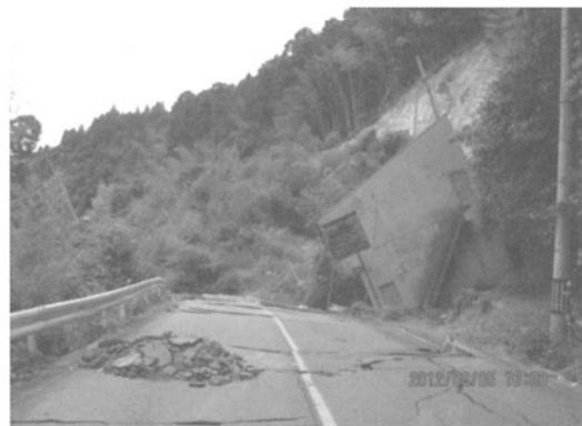
写真-2 星野村柳原地区の道路に沿った斜面崩壊の状況
