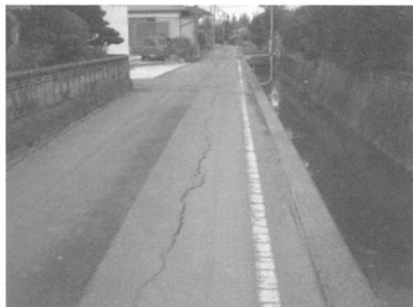
写真-1 不同沈下による道路の亀裂(撮影地点は図-9内)
