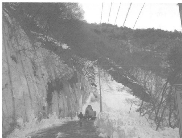
写真-9 雪崩発生状況 (山梨県甲府市)
