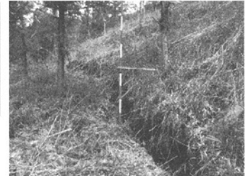
写真-9 I地区の滑落崖山側の亀裂
