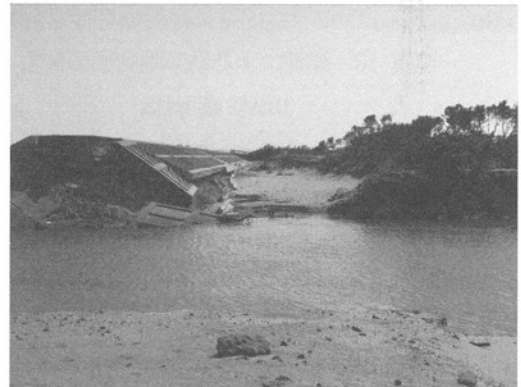
写真-9 津波により破壊された防波堤
