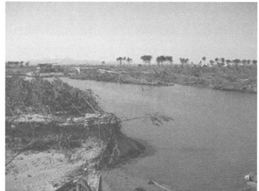
写真-8 津波の浸食による水路の形成
